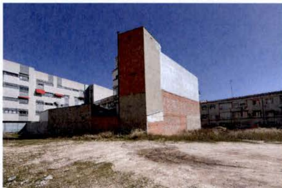
3.- Traseras de la edificación de la c/ Núñez de Balboa
