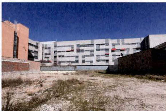
4.-Vista desde la c/ Churruga del interior de la manzana
