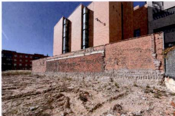
6.- Muro del lindero con la parcela de la Comisaría con el espacio central de la manzana
