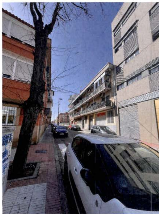
12.- Vista de la calle Núñez de Balboa hacia la c/Churruga. Unión del edificio del ámbito de Ilustración con los existentes en El Rosón
