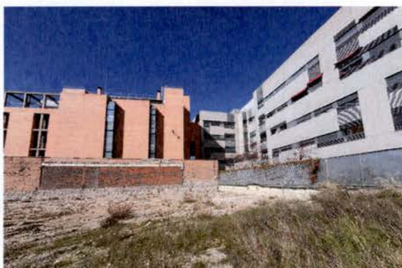
5.-Fachadas a la zona interior de la parcela del edificio de la c/ Ilustración y la Comisaría de la Policía Nacional
