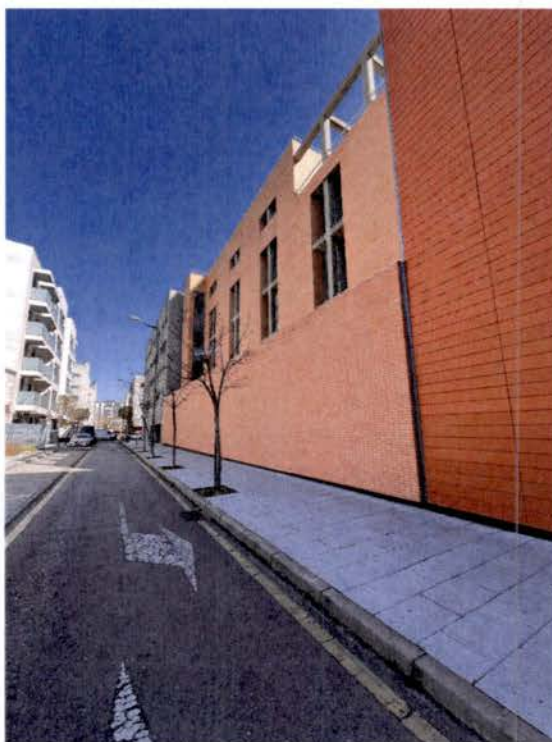
8.-Edificio de la Comisaría, fachada a la c/ José María Peridis
