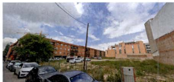
16.- Vista desde la c/ Núñez de Balboa, primer plano medianera de las edificaciones existentes y parcela residencial vacante; al fondo la calle Churrucá, interior manzana y el edificio de la comisaría
