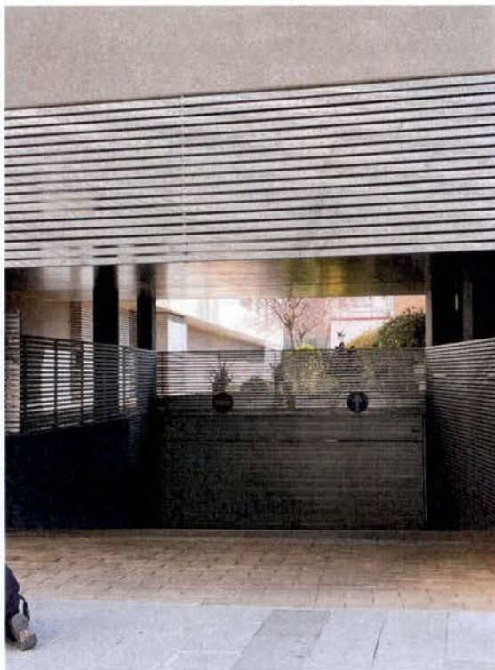
9.- Vista desde la c/ José María Peridis del acceso al edificio residencial de la c/ Ilustración. Patio interior ajardinado
