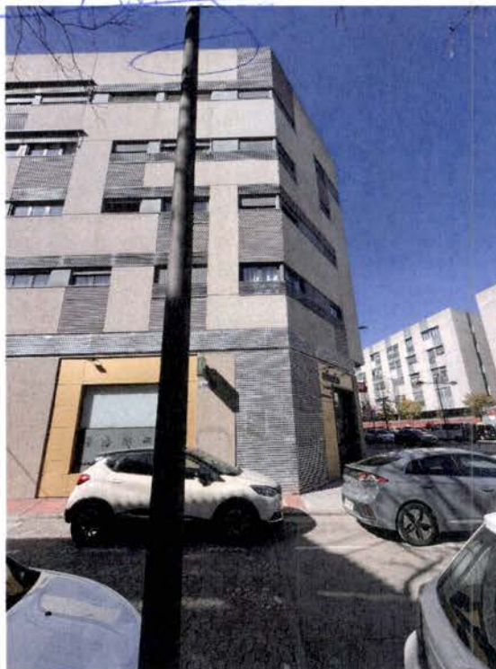
11.- Edificio de la c/ Ilustración, vista de la esquina con la c/ Churruga
